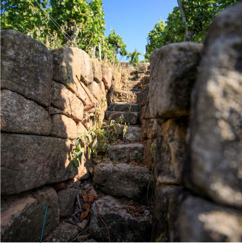
Die charakteristischen Steillagen werden instand gesetzt und so erhalten
