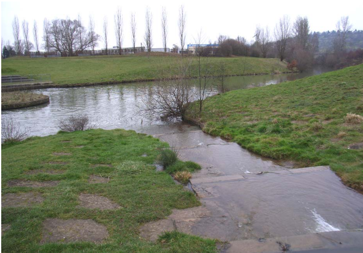
Abb.8: Nach der Unterführung wird der bis eben verdolte Altbach über Kaskaden in den Neckaraltarm geleitet
