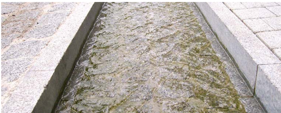
Abb. 6: Pflastersteine sorgen für die geriffelte Wasseroberfläche und erzeugen Spannung
