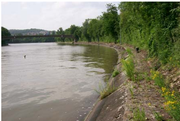
Abb. 1 und 2: Betonierte Ufer rechts und links der Schleuseninsel
