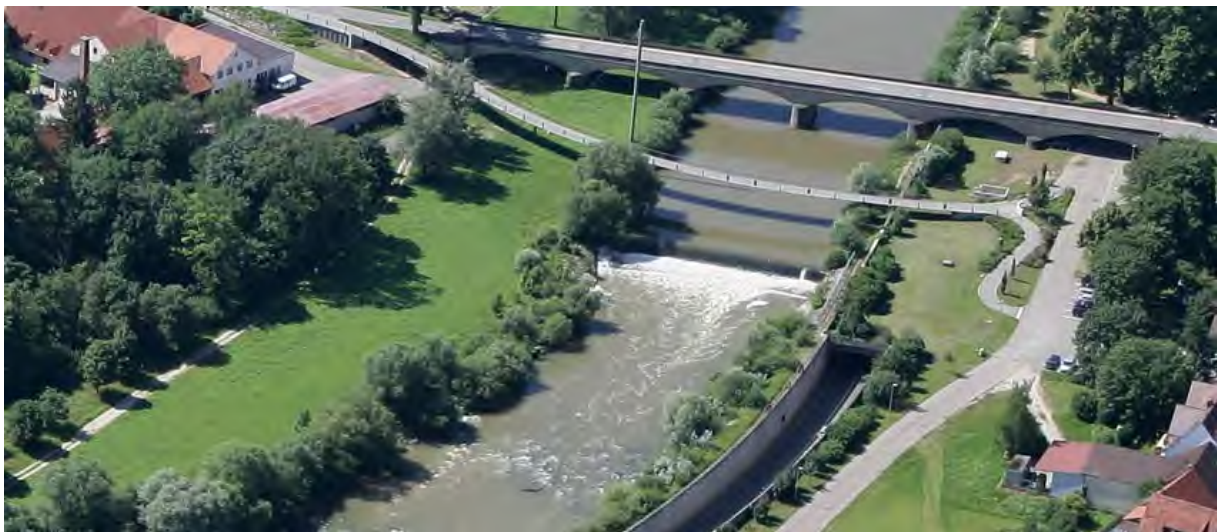
Abb.1: Sohlschwelle unterhalb des Fußgängerstege (Quelle: Achim Mende)
