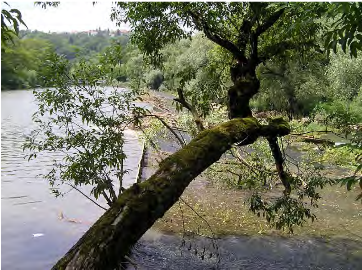
Abb.1: aktueller Zustand des Neckartenzlinger Streichwehrs, in der Mitte ist der schmale Fischaufstieg zu erkennen
