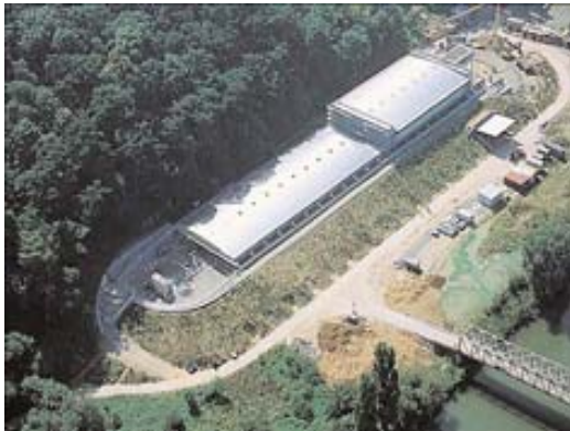
Abb. 1: Sandfang Hofen mit provisorischer Baubrücke (Quelle: Klärwerk Stuttgart-Mühlhausen)
