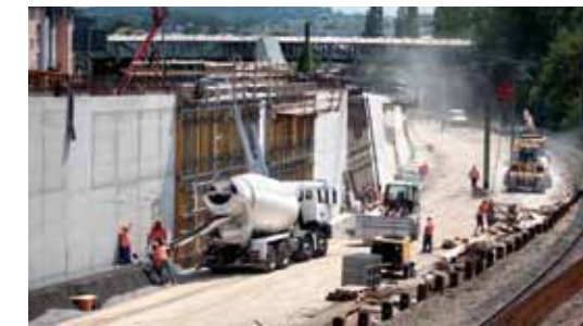
Die S60-Bauarbeiten hatten es in sich
